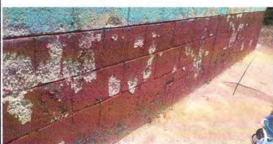
Foto 11: REPARACION DE PAREDES
