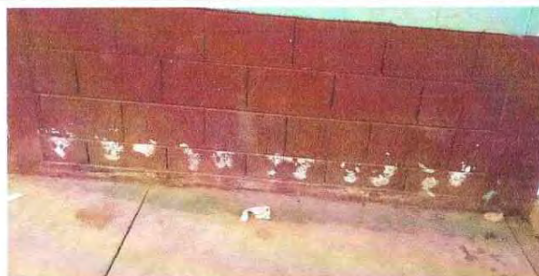
Foto 4: PINTURA DE PAREDES
