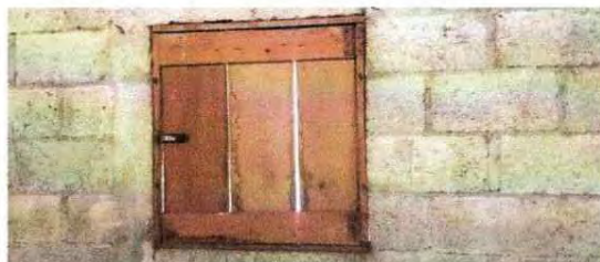
Foto 2: SUSTITUCION DE VENTANA
