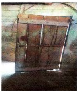
Foto1: SUSTITUCION DE PUERTA
