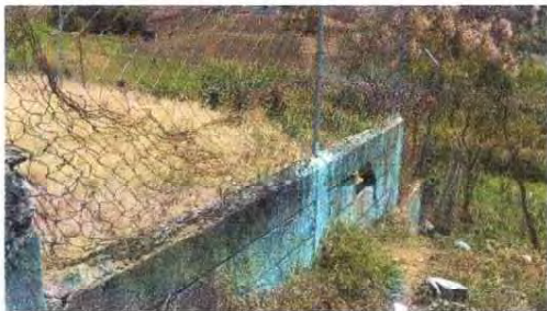
Foto 7: REPARACION DE MURO
