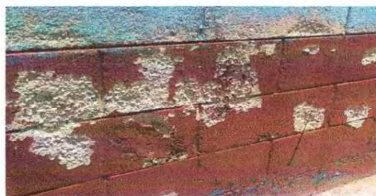
Foto 12: REPARACION DE PAREDES
