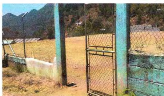
Foto 2: SUSTITUCION DE PORTON
