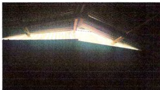
Foto 10: REPARACION Y SUSTITUCION DE TECHO
