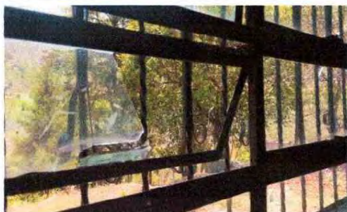
Foto 1: REPARACION DE VENTANALES
