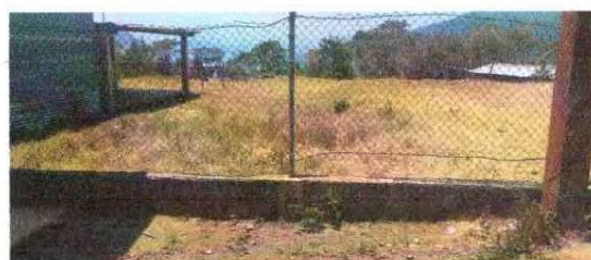
Foto 6: REPARACION DE MURO PERIMETRAL
